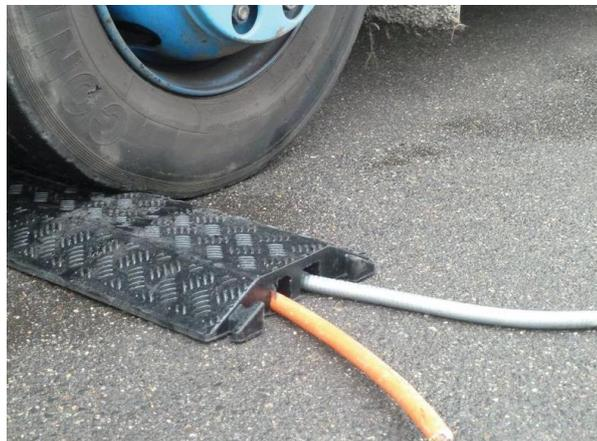
La surface du protège-câble est striée et il supporte des charges jusqu'à 10 tonnes.
